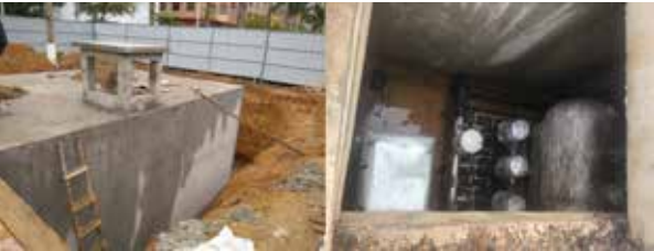
图3 建设中的一处泵站及部分设备
