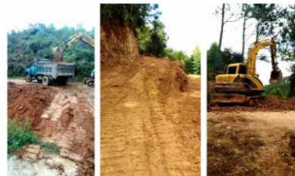
图2 近期主路拓宽及硬底化现场图
