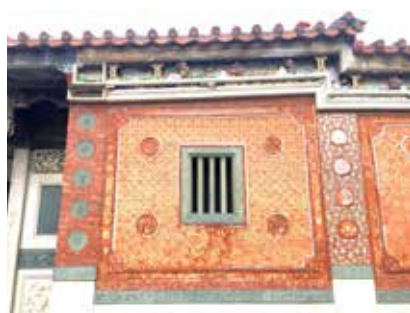
泉州民居封堵墙面砖饰
