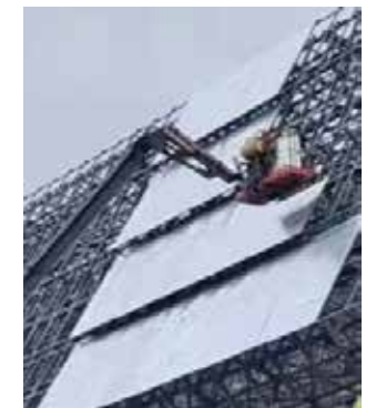
钢平板安装现场图
