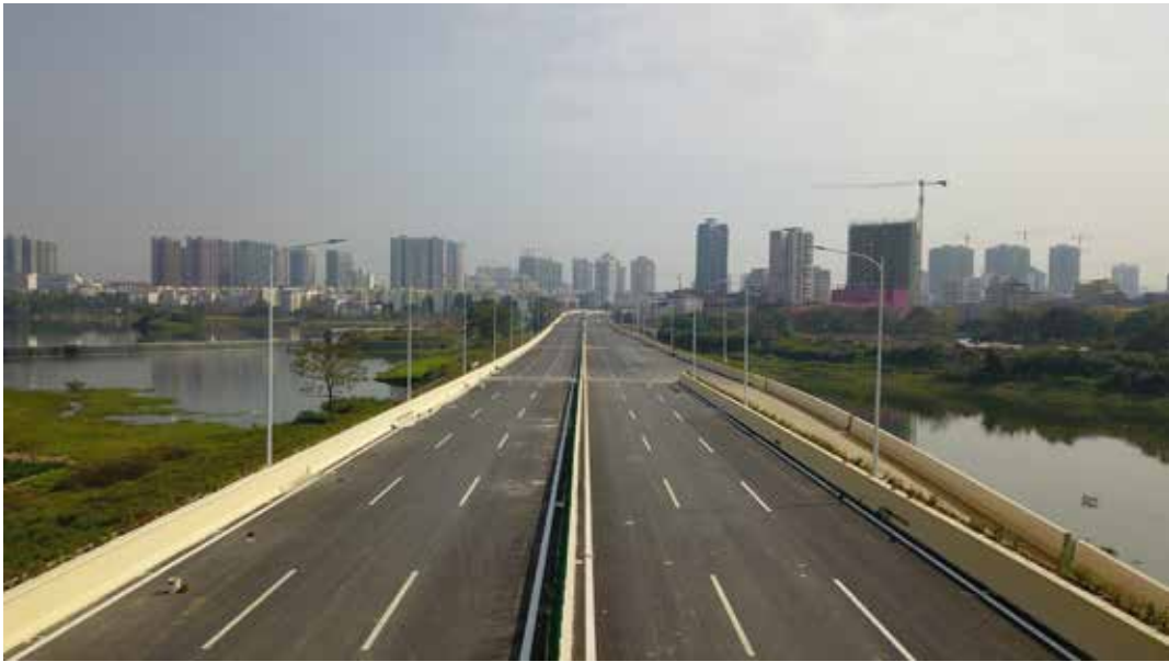
图2 南宁市东西向快速路工程——大西段主线桥梁航拍图
