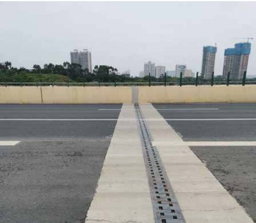
图4 大西段主线桥梁伸缩缝未积水
