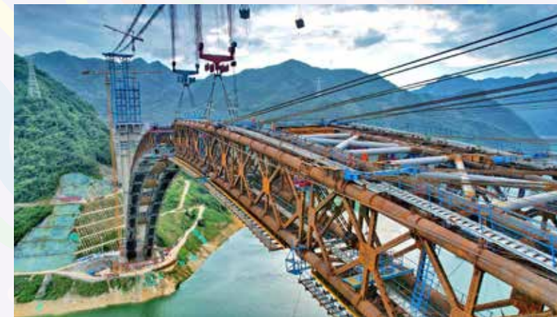
天峨龙滩特大桥施工现场 (图片来源: 广西大学官网)
