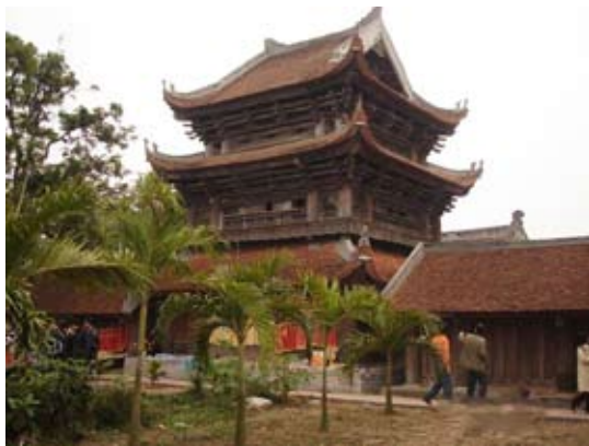
__神光上寺钟楼是全寺最高建筑，也是越南现存最有价值的木结构建筑。
