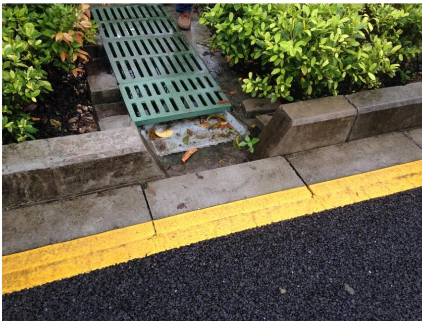
图 6-12 路面雨水断接典型实景图三
