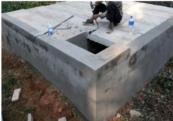
图 6-17 钢筋混凝土蓄水池施工图片（网络图片）
