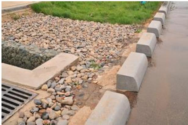
图 6-10 路面雨水断接典型实景图一（开口路缘石）
