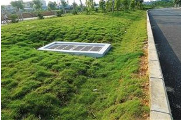
图 5-2 下沉式绿地典型实景图（网络图片）
