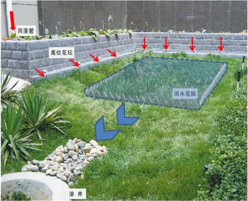
屋面雨水—高花坛—绿地雨水断接（网络图片）
